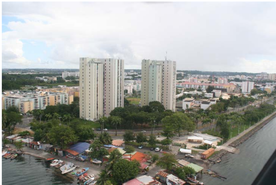
Figure 27 : La zone de basse altitude à forts enjeux de Lauricisque (Photo BRGM)
