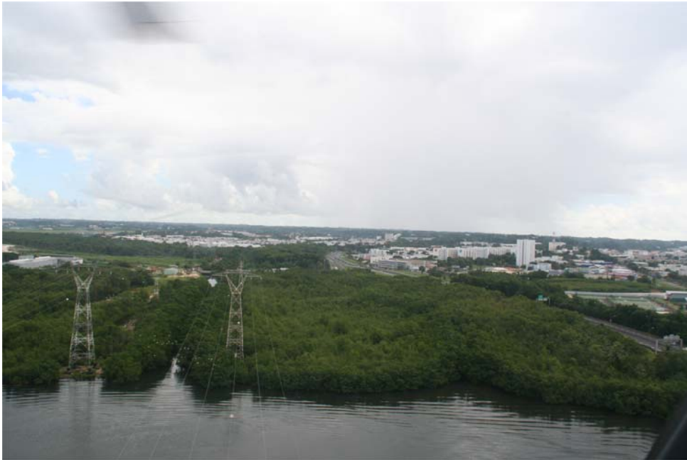
Figure 14 : Le réseau électrique HTB en bordure de la Rivière Salée (photo BRGM)
